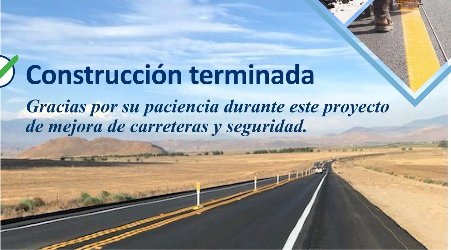
Este proyecto rehabilitó 9.25 millas de carretera en Ramona Expressway usando una mezcla de recubrimiento de asfalto, recuperación de pavimento, reconstrucción y sello de lechada. Además, la ciudad de San Jacinto rehabilitó aproximadamente 1 milla del carril exterior en dirección oeste de Ramona Expressway, entre Warren Road y Sanderson Avenue, en San Jacinto.
